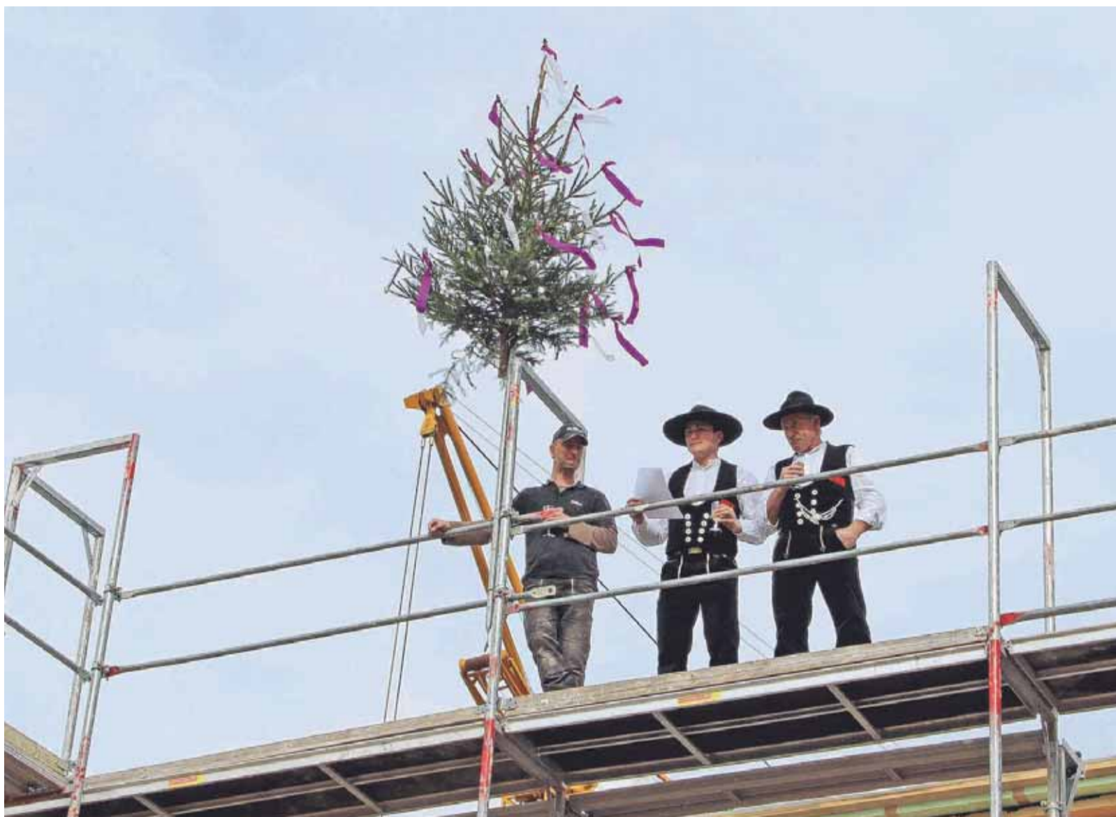
Mit einem Richtspruch eröffnen die Gesellen das Richtfest im Erweiterungsbau.
