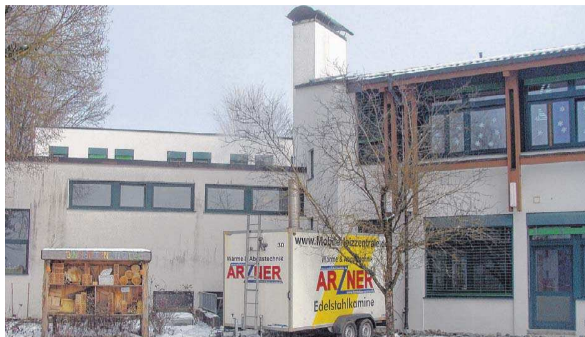
Defekte Heizung: Eine mobile Heizzentrale versorgt die Göge-Schule derzeit mit Energie. FOTO: CHRISTOPH KLAWITTER
